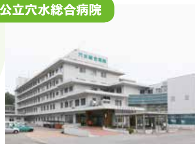
公立穴水総合病院
