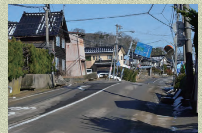
▲ 液状化現象(内灘町内)
