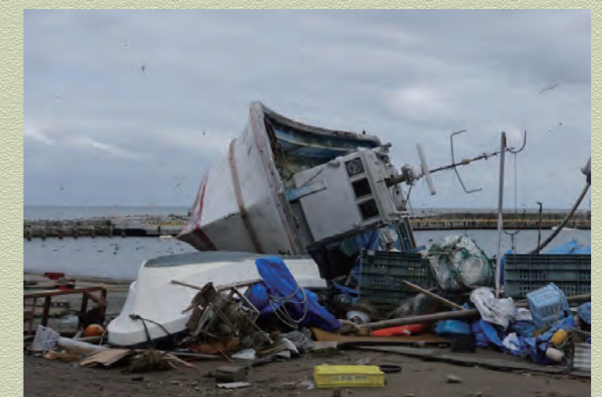
▲ 津波被害(珠洲市内)
