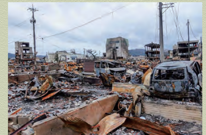
▲ 火災被害(輪島市内)
